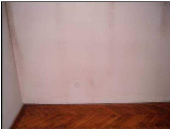
**Bild 1:** Schimmel an Metalprofilen
