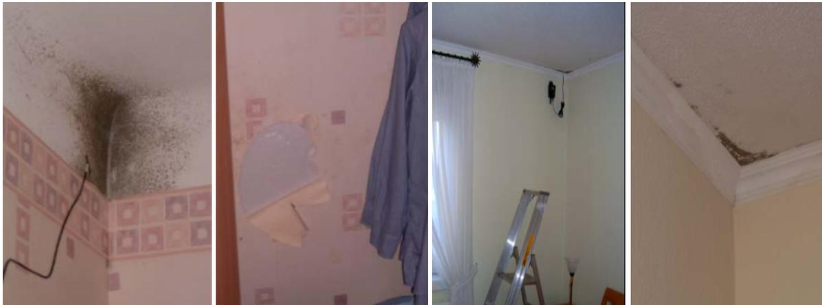
Bild 4: Bilder mit Innendämmung aus Polystyrolplatten
