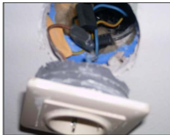
**Bild 2:** Undichte Stelle (Steckdose)
