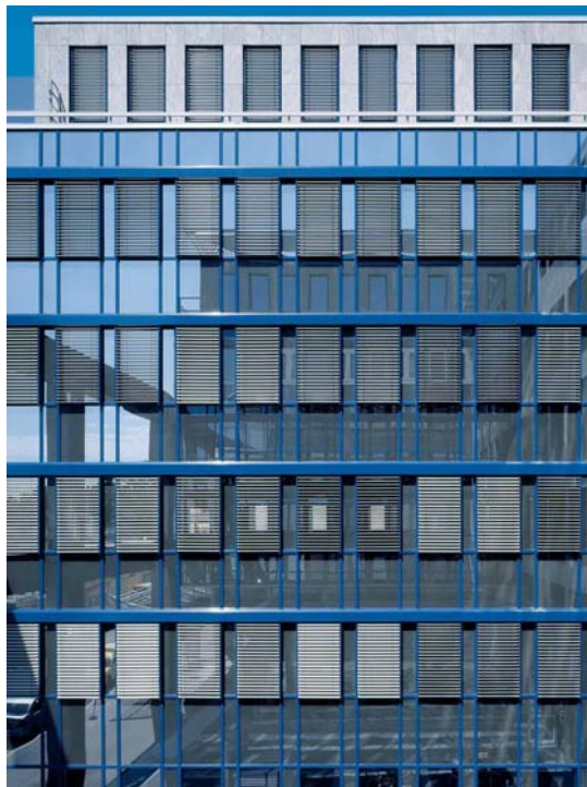
Abbildung 5-2 Bürogebäude mit Beschattungssystem [12i]
