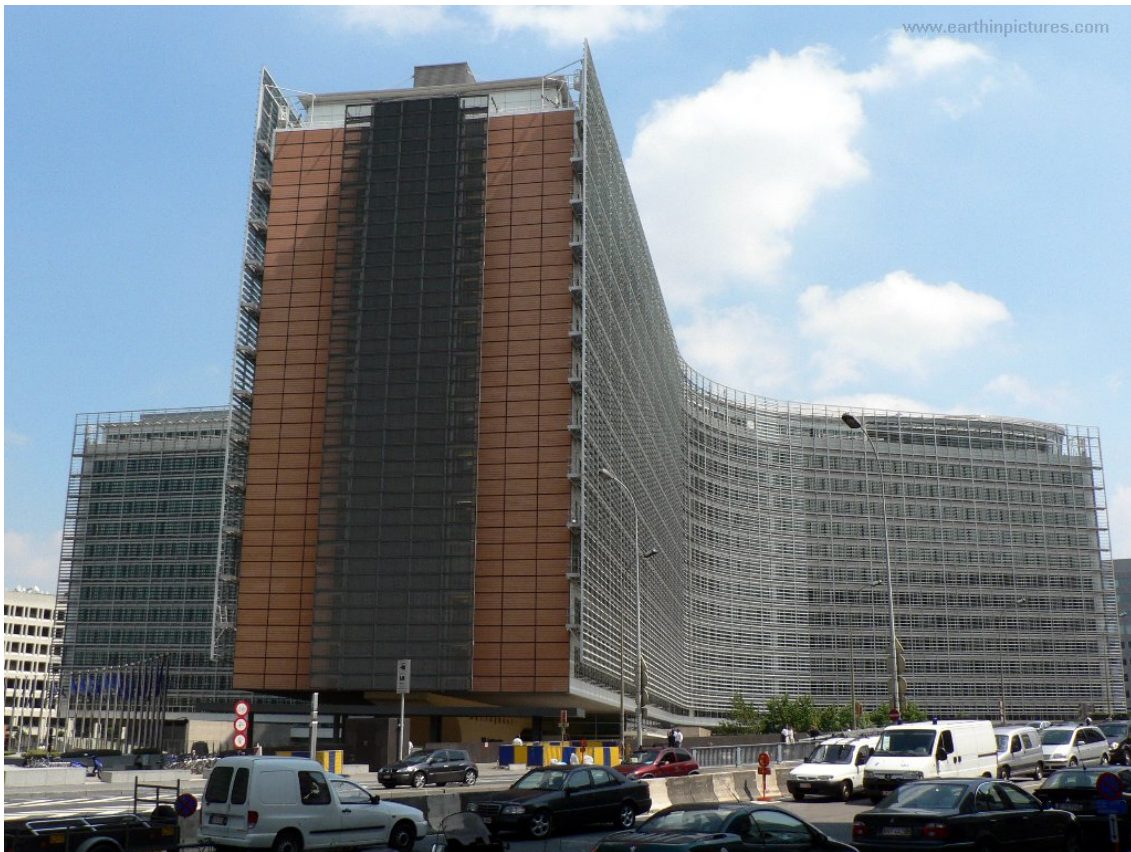
Abbildung 1-4 Ansicht Berlaymont Gebäude [5i]
