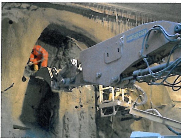
Abb. 5 Kleinteiliger Baggervortrieb
