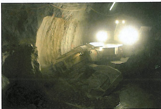
Abb. 4 Lösevorgang mit Teilschnittmaschine
