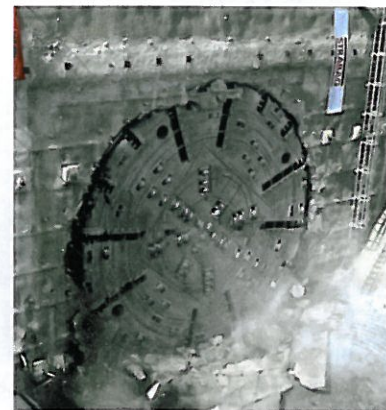
Abb. 7 Durchschlag TBM-S Reiserbergtunnel Perschling
