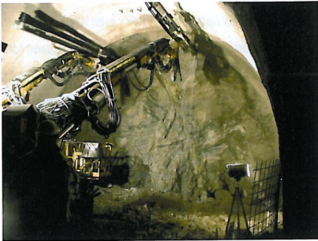
Abb. 3 Kalottenvortrieb Sprenglochbohrung
