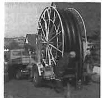
Abb. 45. Einzug Inlinerrohr
