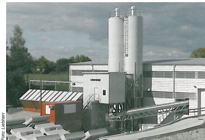
Flexible Anlagenkonzeption: Compactmix 1,0 A-R konnte nahtlos an die bestehende Produktionshalle angegliedert werden.
