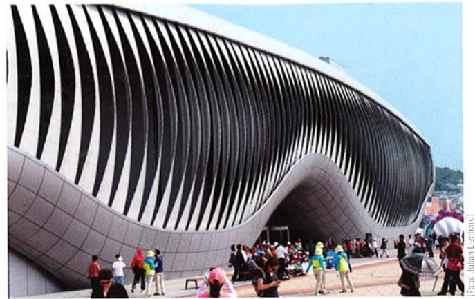
Bild 12 Themenpavillon mit geöffneten Lamellen Thematic pavilion with opened louvers
