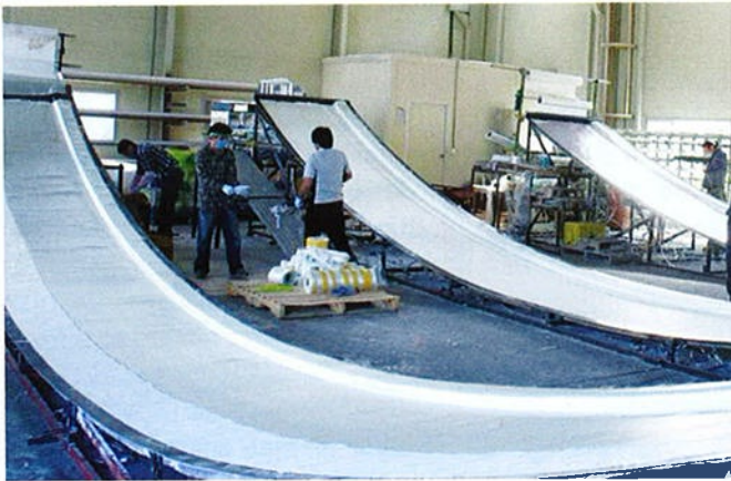
Bild 11 Lamellen während Fertigung/Montage vor Ort Louvers during fabrication/installation on site
