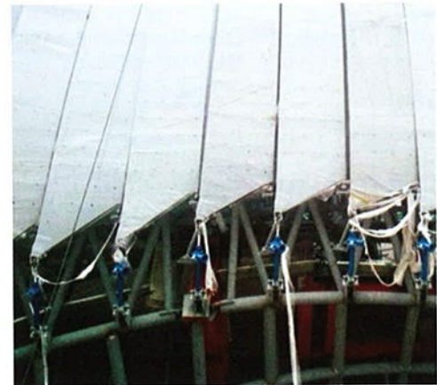
Bild 13 Montage vor Ort Installation on site
