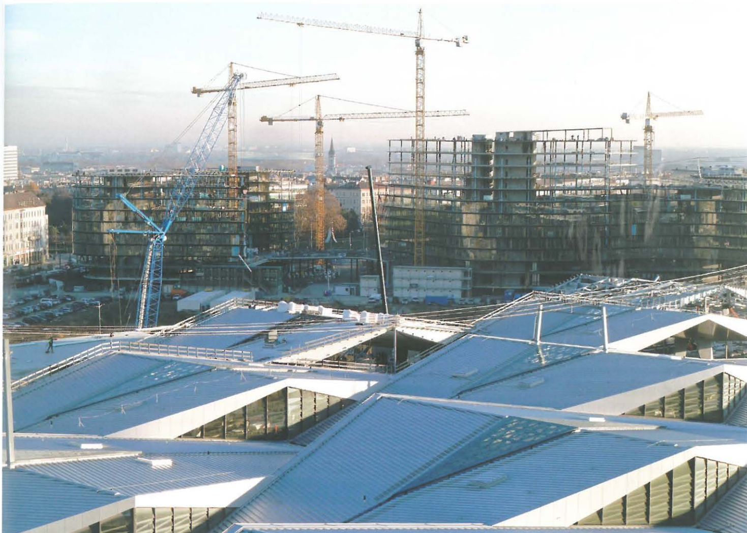
Kooperative Zusammenarbeit der Projektbeteiligten ist besonders bei komplexen Bauvorhaben, wie dem Hauptbahnhof Wien, aber auch bei den benachbarten Hochbauten für eine erfolgreiche Projektabwicklung wesentlich.
