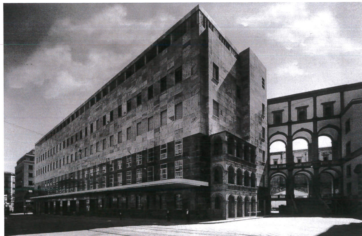
Fig.2. Naples, the Palazzo delle Poste on Via Monteoliveto, Naples, 1936
