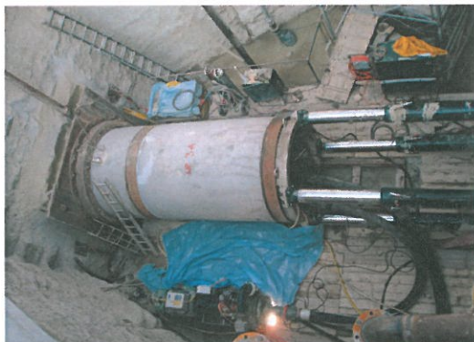
Grabenloser Leitungsbau
