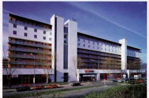
Wohnpark Trillergasse, Wien 21
