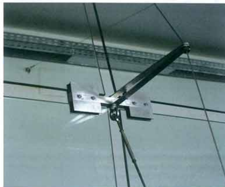
Aussteifung – Stahlseilhalterung Detail
