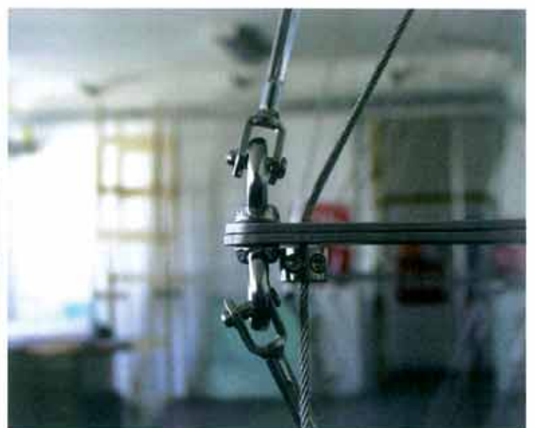
Aussteifung – Stahlseilhalterung Detail
