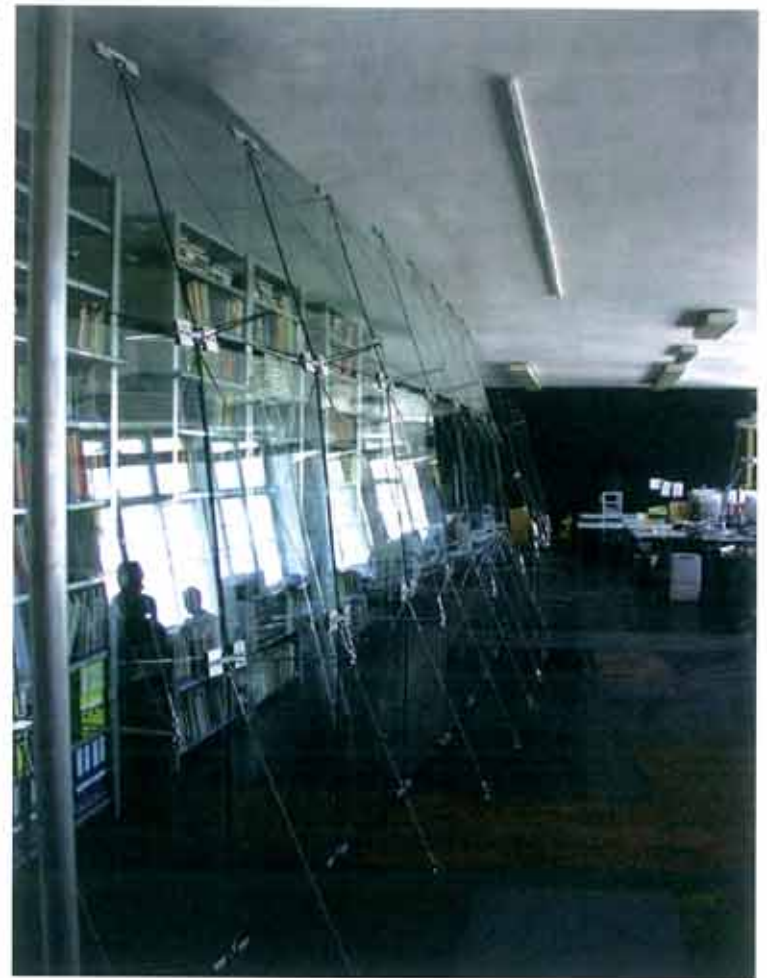
Glaswand als Raumteiler den Räumlichkeiten der Abteilung Hochbau und Entwerfen 253/4 an der TU Wien
