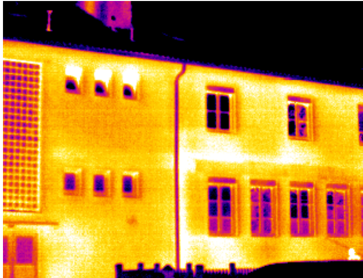
Abb. 15: Westansicht, Wärmebrücken im Deckenbereich Speisesaal, Bericht Thermografie EVN AG (2001)
