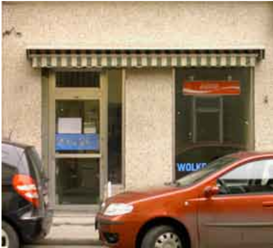
Abb. 4.12: Fassade Kaiserstraße 34 Foto: Reingruber&Stammler
