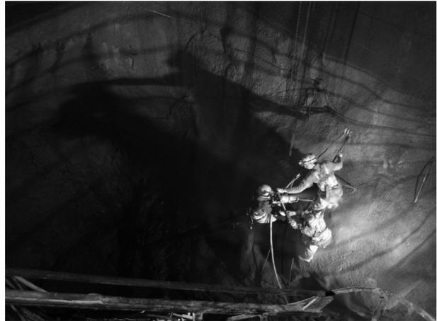
Abb. 5 Steigschacht – Arbeiten der Mineure am Seil
