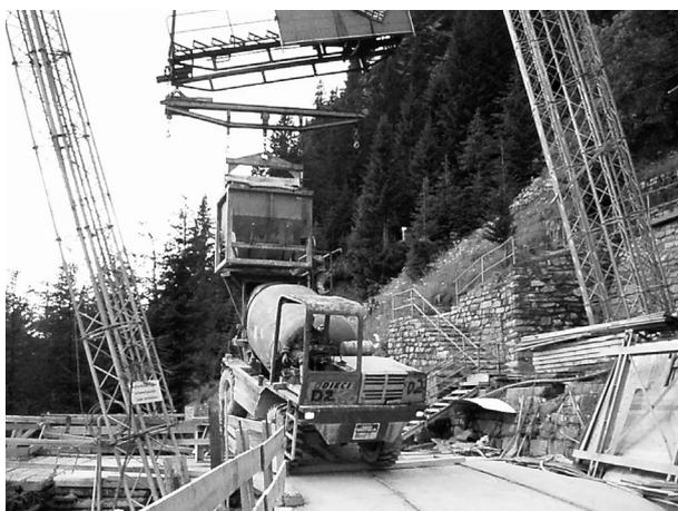
Abb. 11 Betonumschlag Seilbahn Bergstation
