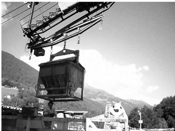
Abb. 10 Betonumschlag Seilbahn Talstation
