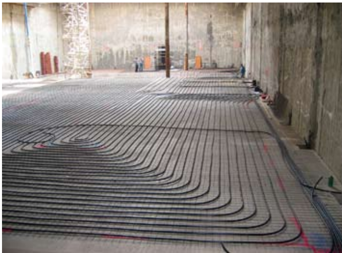
Abb. 4: Absorberleitungen auf der Sauberkeitsschicht unterhalb der Bodenplatte bei der Station U2/3. Rechts sind die Anschlussstellen für die Einbindung der Schlitzwandelemente zu erkennen.
