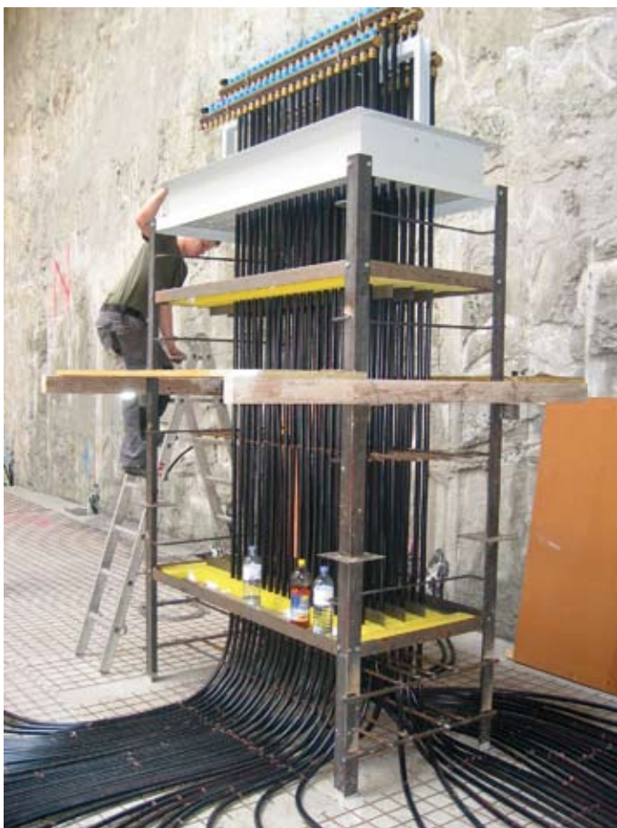
Abb. 5: Druckwasserdichte Durchführung der Absorberleitungen durch die herzustellende rund 2 m starke Bodenplatte. Die gelben Schaumkörper sind in 2 Horizonten angeordnet und dienen als Platzhalter für das Ausinjizieren nach Fertigstellung der Bodenplatte.
