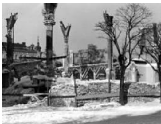
Abb. 9 Abbruch der Synagoge, Januar / Februar 1940
