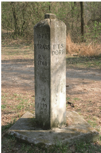
Abb. 1: Beispiel für einen Grenzstein mit besonderer Bedeutung (links: Foto H. König, 2012; rechts: Darstellung auf Basis der Digitalen Katastralmappe, Quelle: Bundesamt für Eich- und Vermessungswesen). Der Stein stammt aus dem 17. Jahrhundert. Bei ihm stoßen 6 Grundstücke, 5 Katastralgemeinden (daher ist er fünfeckig), 3 Ortsgemeinden, 2 Bezirke und 2 Viertelgrenzen Niederösterreichs zusammen. Eine besondere Kombination.
