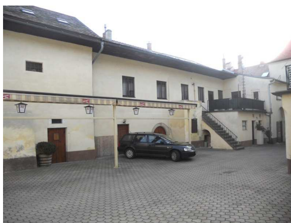
Abb. 4.4: Innenhof Ansicht Osttrakt
