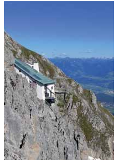
Abb.1.3.13 Die Bergstation Hafelekar der Nordkettenbahn von 1927/28
