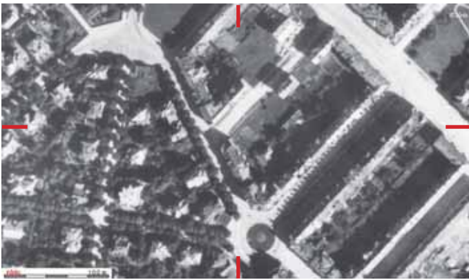
Abb.2.1.12 Luftaufnahme der Gutenbergstraße von 1940
