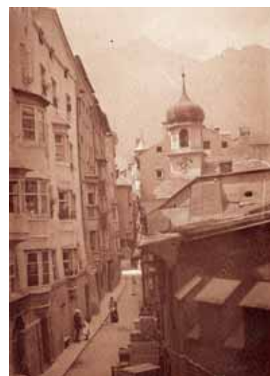
Abb.1.1.10 Das Gebäude links in der Schlossergasse diente als Synagoge
