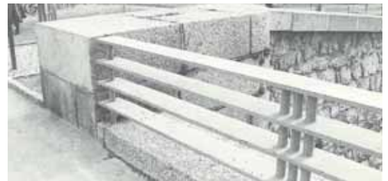
Abb.5.3.54 Geländer der Universitätsbrücke
