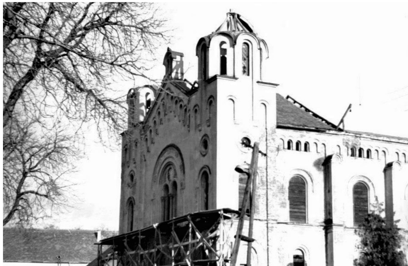
Abb. 51: Tempel während Renovierungsarbeiten
