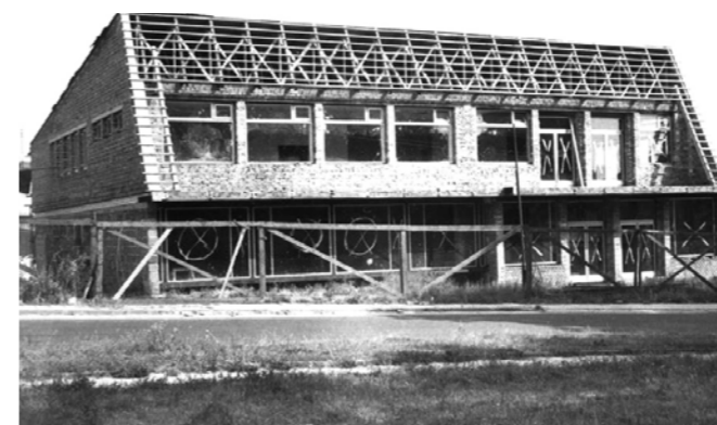
Abb. 55: Rohbau des Selbstbedienungsladens
