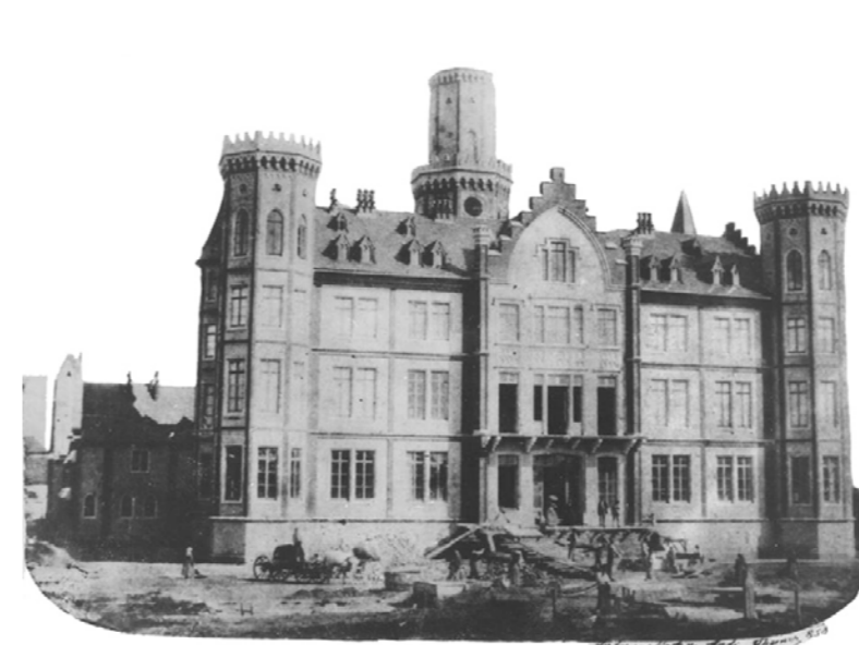
Abb. 49 (oben): Schloß während Umbauarbeiten
