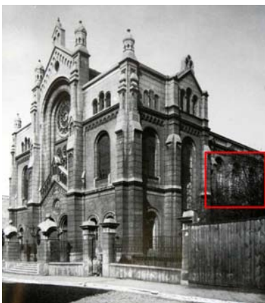
Abb.77: Fenster 1.OG, Gebetshalle
