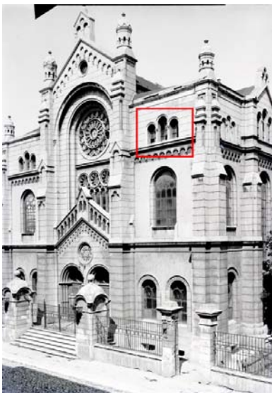
Abb.60: Markierung, Fenster 2.OG
