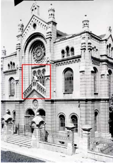
Abb.62: Mittelrisalit, Fenster 1.OG
