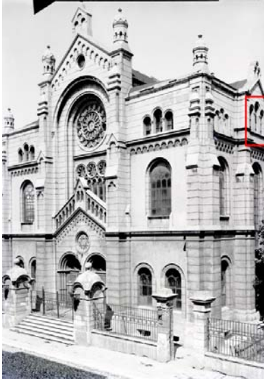
Abb.74: Markierung, Fenster 2.OG (Stiegenaufgang), Seite
