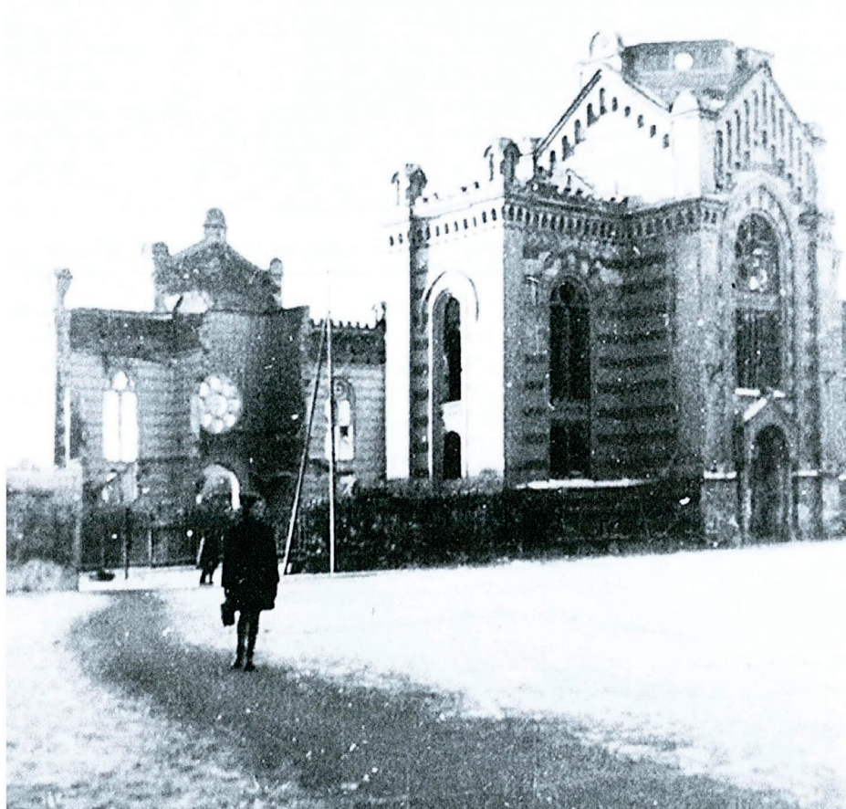
Abb. 41. Dem Bild der teilweise abgerissenen Synagoge konnte entnommen werden, dass die Stiegenhäuser auf der Rückseite des Gebäudes, ähnlich der Fassade, gestreift ausgemalt waren.
