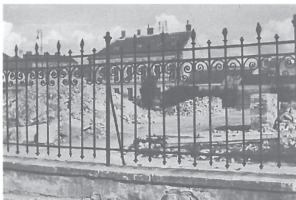
Abb. 06. Hinter dem Zaun der ehemaligen Synagoge ist zu erkennen, dass die Baumaterialien zur weiteren Verwendung sortiert wurden.
