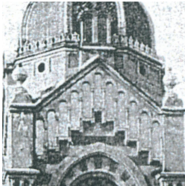
Abb. 56. ... und als Ausschnitt eines Fotos, als Vergleich zum ausgeführten Zustand.
