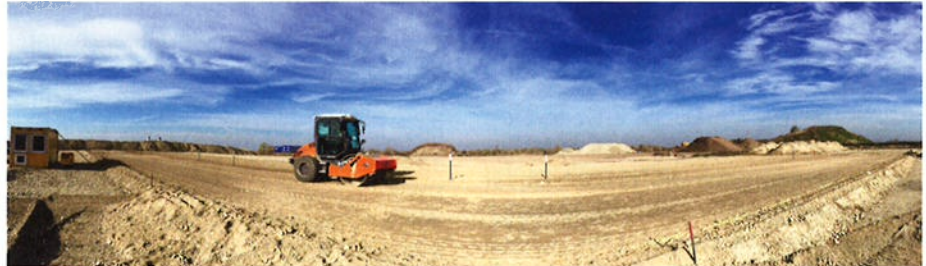
Abb. 6: Erprobung des FDVK-Systems für Oszillationswalzen unter Baustellenbedingungen mit einem HAMM H7i VIO Walzenzug
