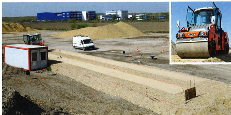
Abb. 2: Fotografie des Testfeldes und der Messwalze der experimentellen Untersuchungen
