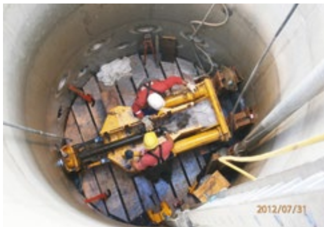
Abb. 4 Herstellung des Entnahmehrunnens nach dem Ranney-Falley-Verfahren.
