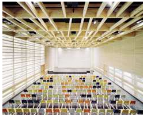
Nach dem Prinzip „Raum im Raum“ in die Sichtbetonhalle eingestellter „hölzerner Saal“
