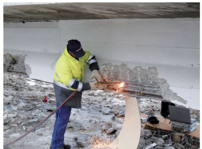
Bild 9. Durchtrennen der Spannglieder mittels Schneidbrenner [9] Fig. 9. Cutting through the tendons [9]
