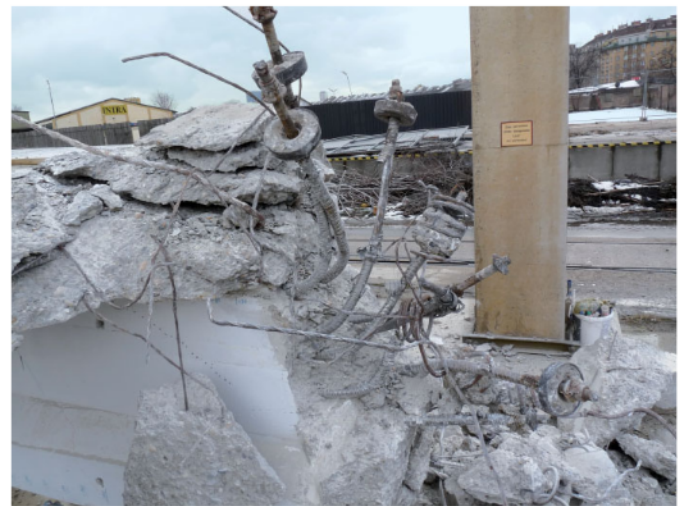
Bild 6. Freigelegte Verankerungen während des Abbruchs
