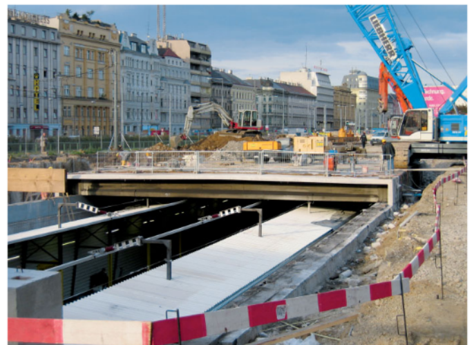
Bild 1. Spannbetonträger während des Aushubs [1] Fig. 1. Prestressed girder at removal [1]
