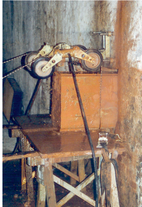
Abb. 4: Seilsäge zur Entnahme von Mauerwerkskleinfeiler Fig. 4: Wire saw for taking a masonry-sample
