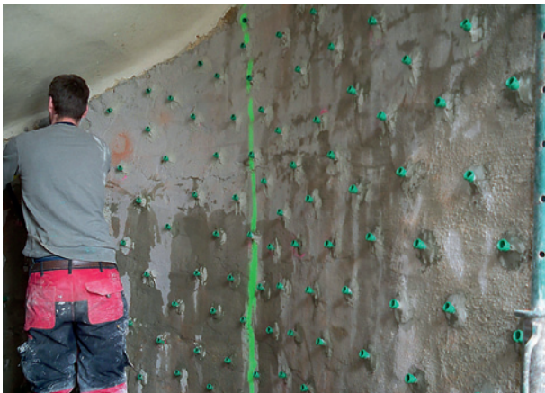
Abb. 11: Injizierte Stiegenhauswand mit Wasserglas und anschließend Mikrozement
