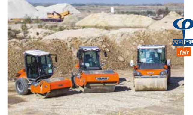
Abb. 5: Die drei Testwalzen zur Erprobung des FDVK-Systems für Oszillationswalzen
