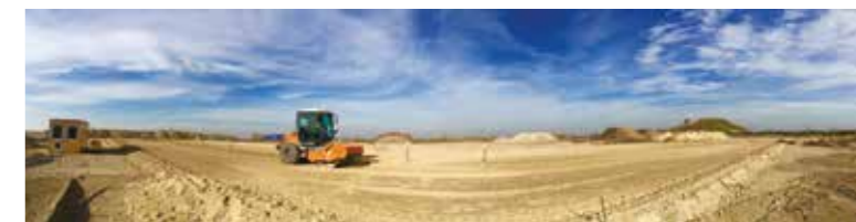
Abb. 6: Erprobung des FDVK-Systems für Oszillationswalzen unter Baustellenbedingungen mit einem HAMM H7i VIO Walzenzug
