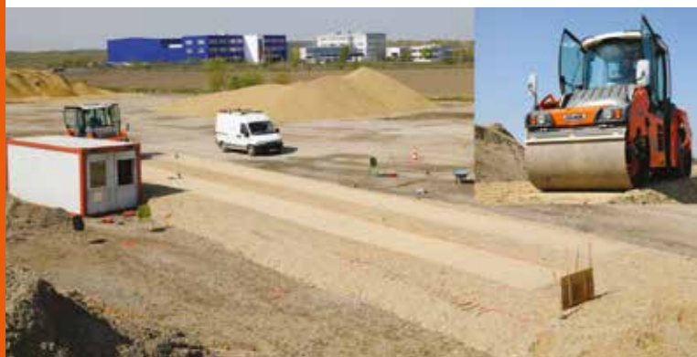
Abb. 2: Fotografie des Testfeldes und der Messwalze der experimentellen Untersuchungen
