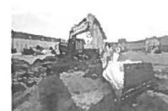
Erdaushub für Fundamente auf dem Heldenplatz. (© Parlamentsdirektion / Johannes Zinner)
