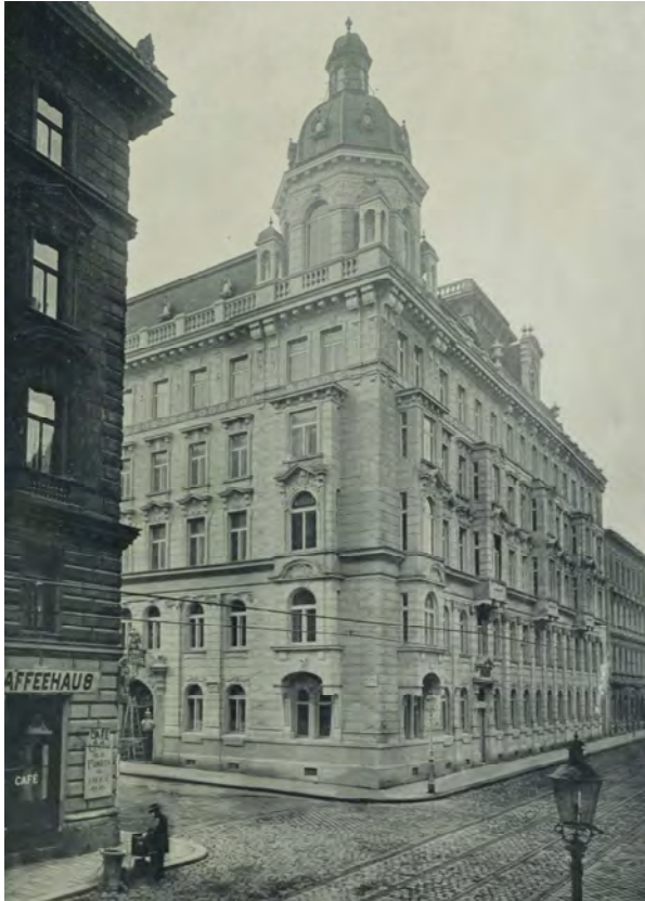
Abb. 9 Geschäfts und Wohnhaus, Burggasse
