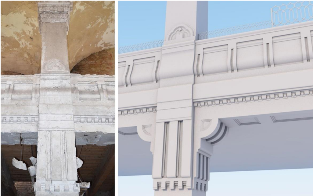
Abb. 67 - Brüstung der Empore
