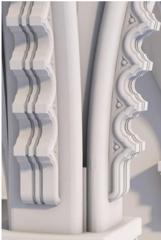
Abb. 71 - Dekorationsprofile am Gewölbebogen Rekonstruiert
