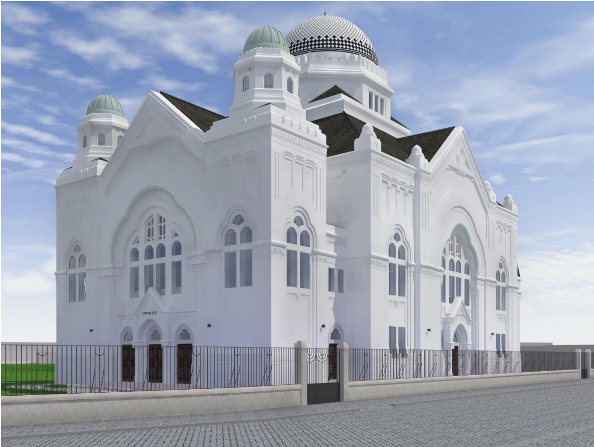
Abb. 95 – Straßenseite – Blickrichtung Nordost
