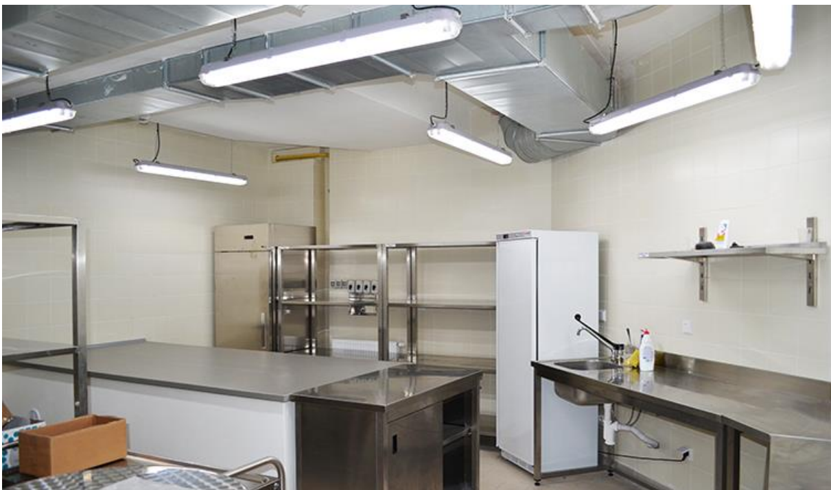
Abb. 122 - Küche und Lager Ostseitig (2017)
