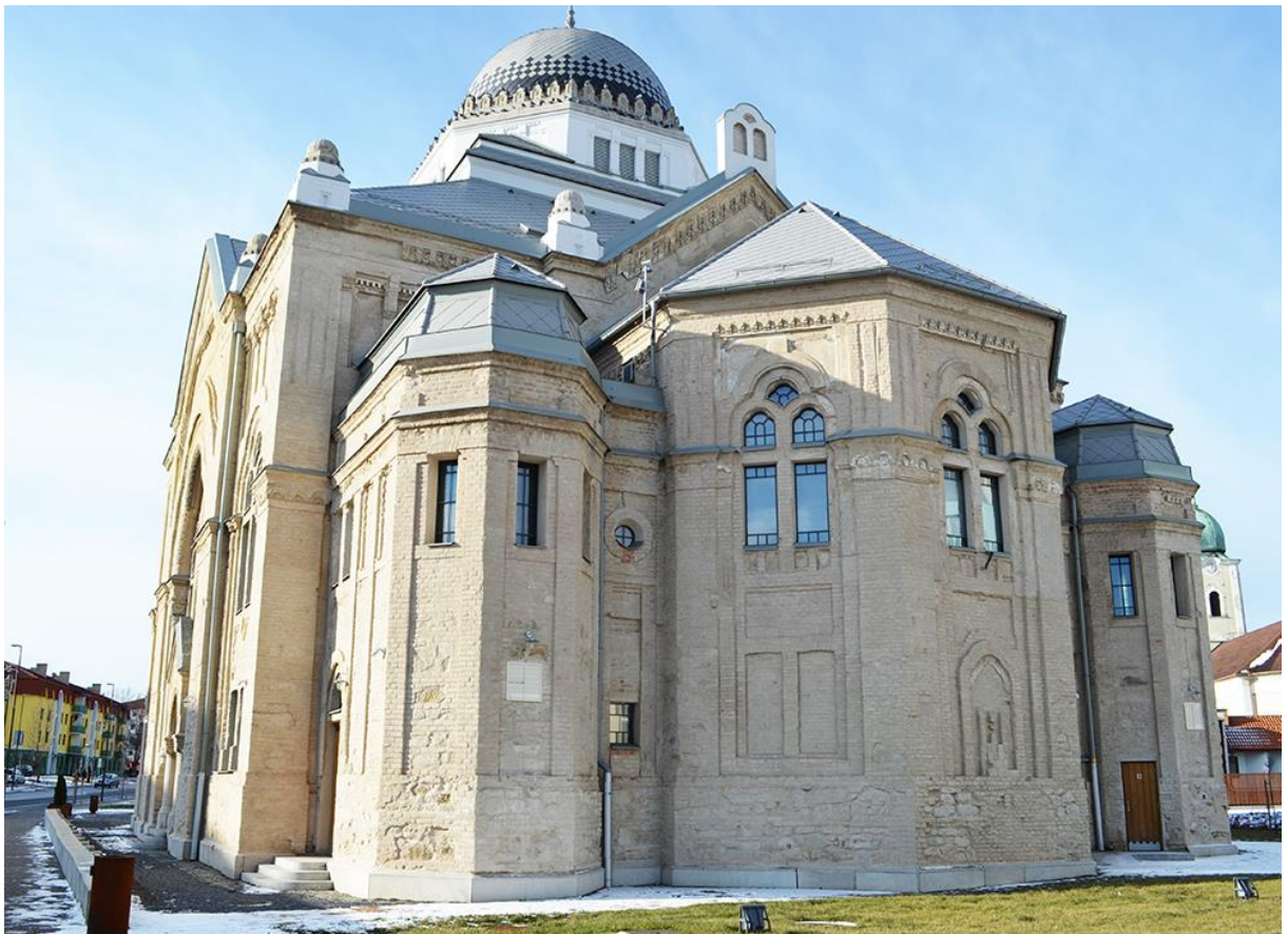
Abb. 113 - Ost- und Südansicht des neuen multikulturellen Zentrums (2017)
