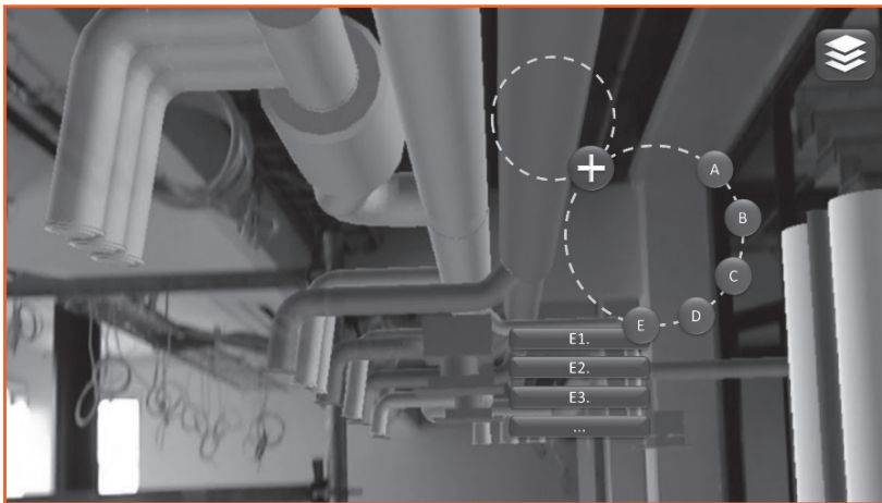
Abbildung 3: Überlagerung der Haustechnik in der realen Umgebung (vgl. Bogna, Entwicklung eines Augmented Reality Interfaces für die TGA-Abnahme [Diplomarbeit, Technische Universität Wien 2019])
