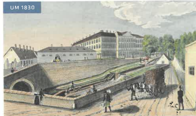
Abb. 5.5 Vom Wasser zur Schiene – die „strukturelle Permanenz“ eines Transportkorridors. Bedingt durch ihre einheitliche rechtliche Verfasstheit, ihre günstige Lage, ihre geradlinige Geometrie und ihr kontrolliertes Gefälle war die Schneise des Wiener Neustädter Kanals im 19. Jahrhundert verhältnismäßig leicht verkehrstechnisch zu „aktualisieren“. Blick von der Beatrixbrücke in Richtung der als „k. k. Tierarznei-Institut“ errichteten heutigen Universität für Musik und darstellende Kunst. Bis zur Auflassung dieses Kanalabschnitts 1848 lag hier die Rabengassen-Schleuse.
