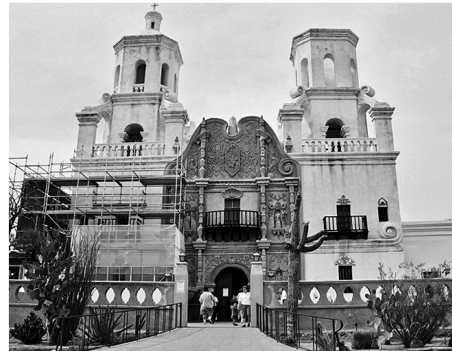
Abb. 8: San Xavier del Bac , Tucson, AZ, 1797, Frontansicht
