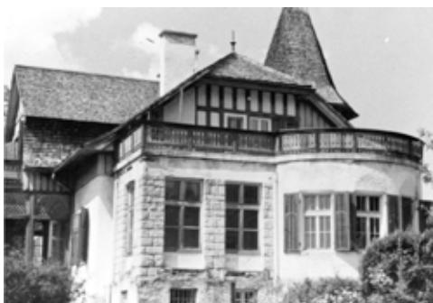
Berghaus vor dem Umbau
